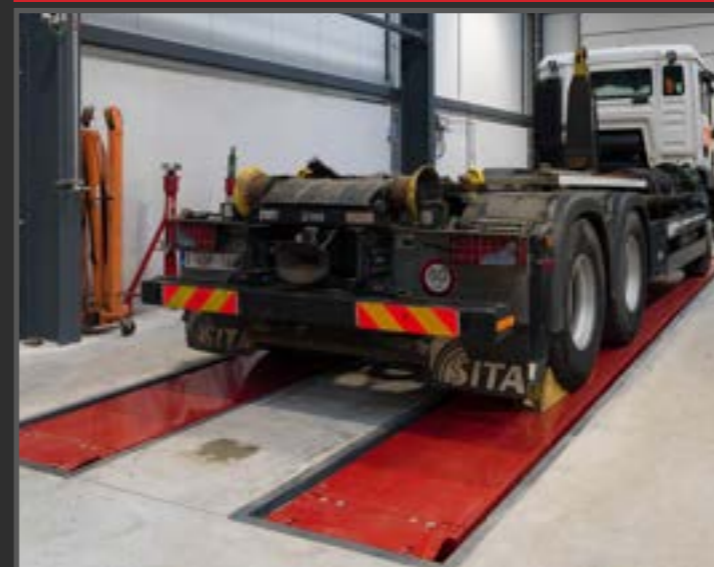
Vlakke vloer: rijbanen + voertuigweerhouders + brugkrik > in ruststand in de vloer verzonken
